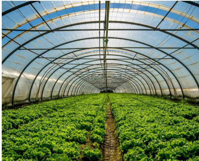
spojenih u jedan koji čine blok plastenik ili staklenik. Staklenici su najkompleksniji i naјsavremeniji oblik zaštićenog prostora. Postavljeni su na betonske temelje, metalne konstrukcije, sa potpuno ili djelimično automatizovanim prosjecima termoregulacije i regulacije zalivanja biljaka.
